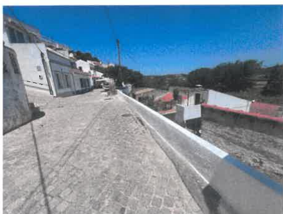
Limpeza e manutenção da Rua do Norte
