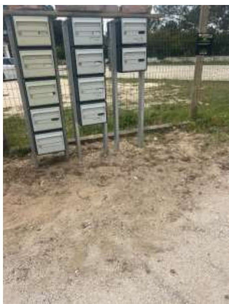
Colocação de caixas de correio
