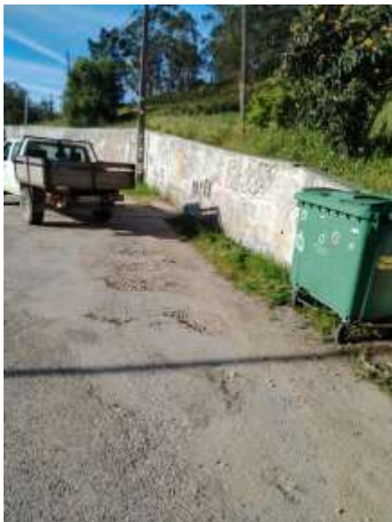
Manutenção de muro - Aljezur
