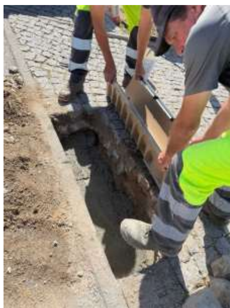
Colocação de grelha
