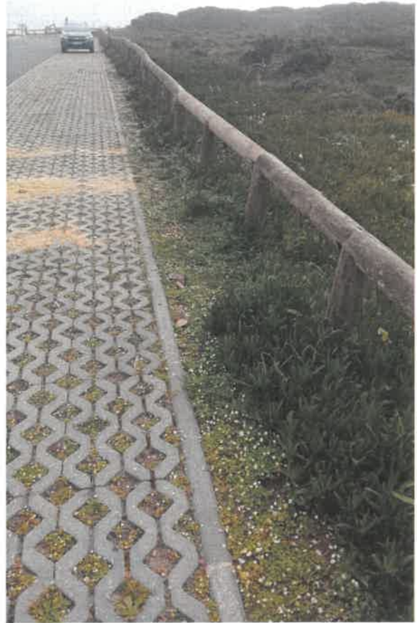
Substituição de postes de madeira – Praia da Amoreira (DEPOIS)
