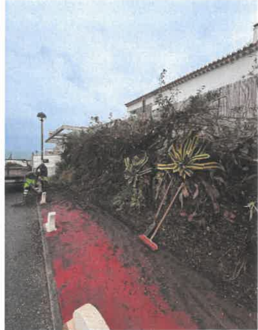
Limpezas de passeios
