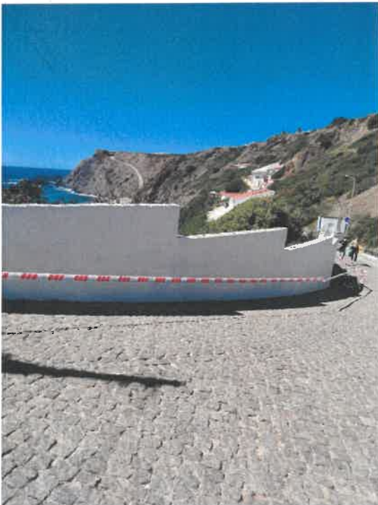
Pintura e arranjos de muros - Praia da Arrifana (DEPOIS)
