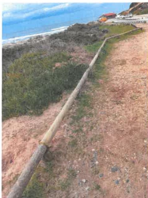
Substituição de postes de madeira - Praia da Amoreira
