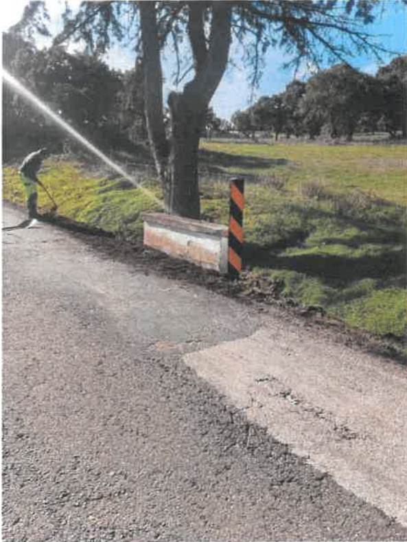
Limpeza de bermas - Alfambras
