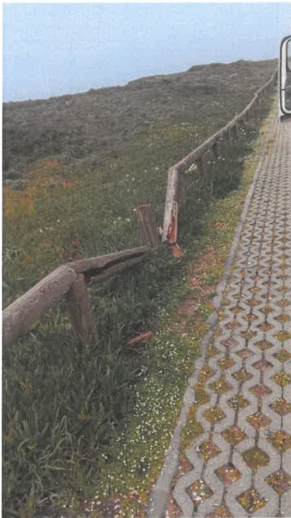
Substituição de postes de madeira – Praia da Amoreira (ANTES)
