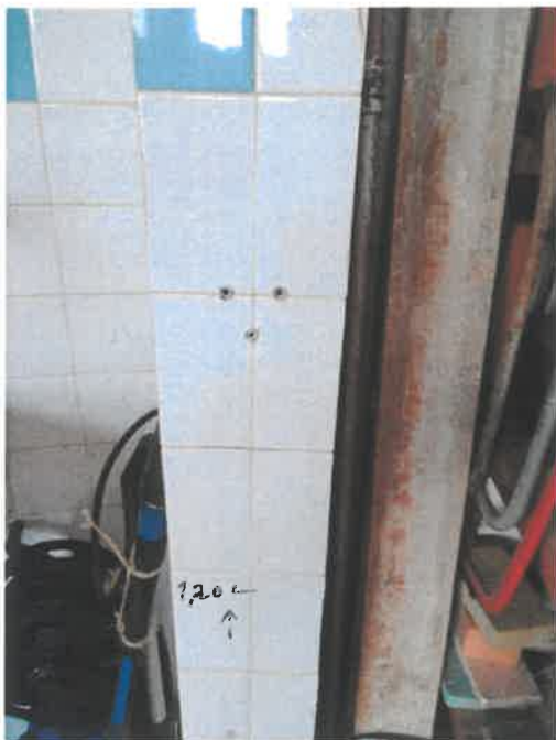
Colocação de extintor
