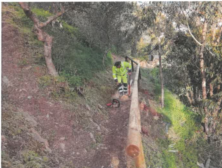
Limpeza e colocação de postes - Vereda de acesso ao caminho das piteiras - Aljezur
