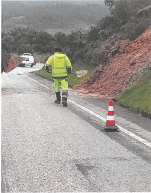
Limpeza de derrocadas nas estradas
