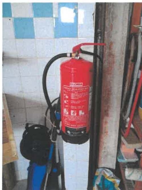
Colocação de extintor
