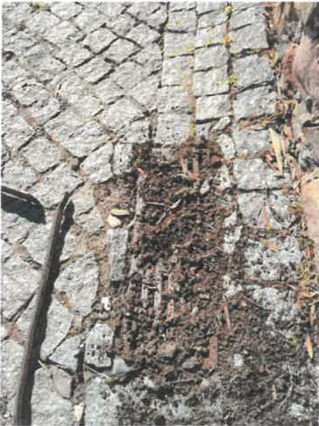
Limpeza de sarjetas – Urb. Arrifamar e Arrifana
