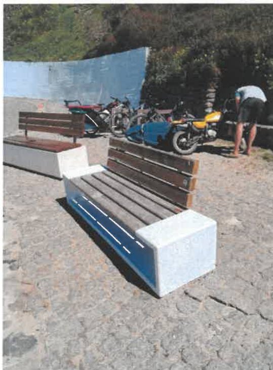
Pintura e manutenção de bancos - Praia da Arrifana (DEPOIS)
