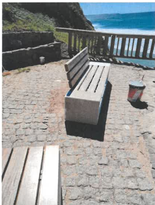
Pintura e manutenção de bancos - Praia da Arrifana (ANTES)
