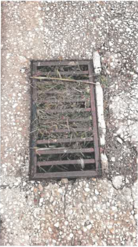
Limpeza de sarjetas – Urb. Arrifamar e Arrifana
