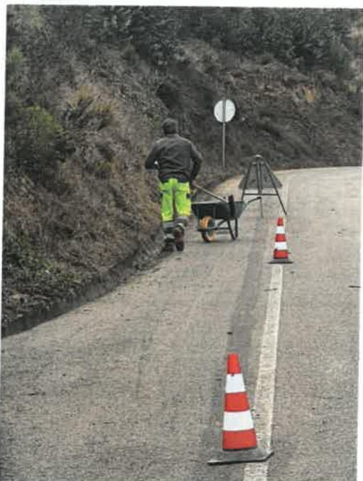
7. Limpeza e arranjos nas bermas
