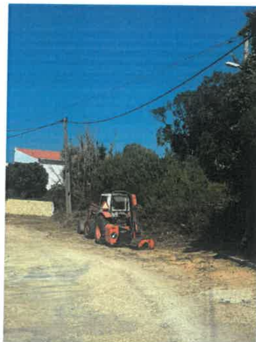
4. Desmatção e limpeza de bermas - Vale da Telha
